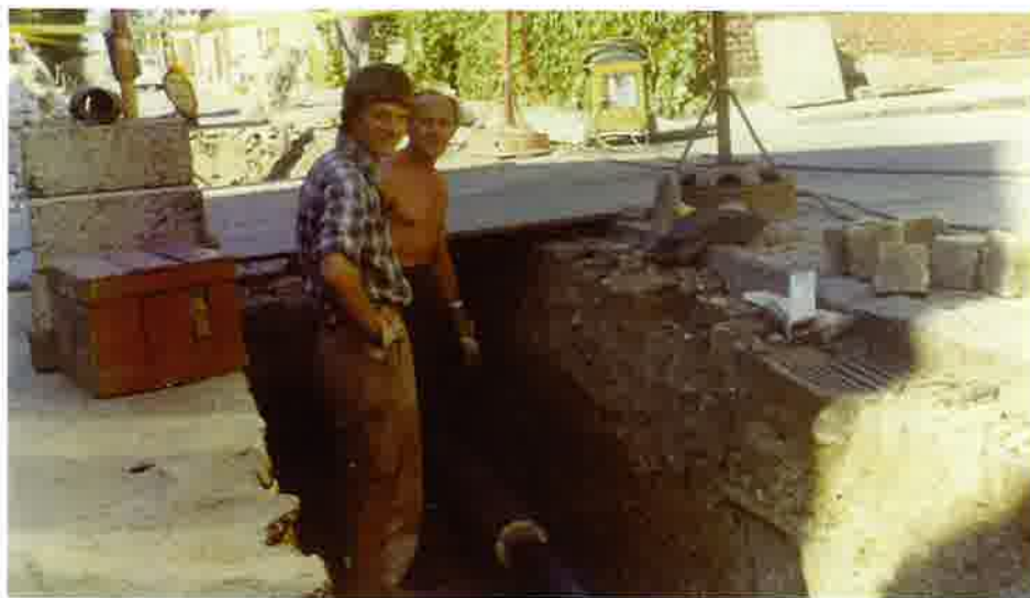
Nedlægning af præisolerede rør omkring 1972. Personerne er Gunnar Mønster og Ove Betzer.
