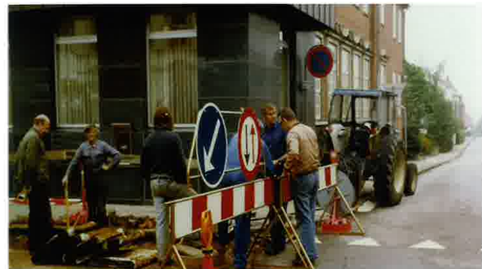
Ledningsarbejde ud for Søndergade nr. 1 omkring 1982.
