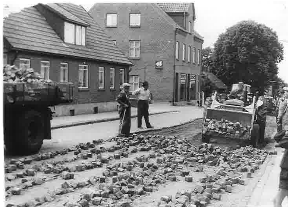
Viborg chausséen opbrydes omkring 1960 for at der kunne støbes betonkanaler til fjernvarmeledningen.
