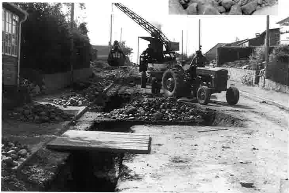
Opgravning for støbning af betonkanal med lyre i Ågade i 1960.
