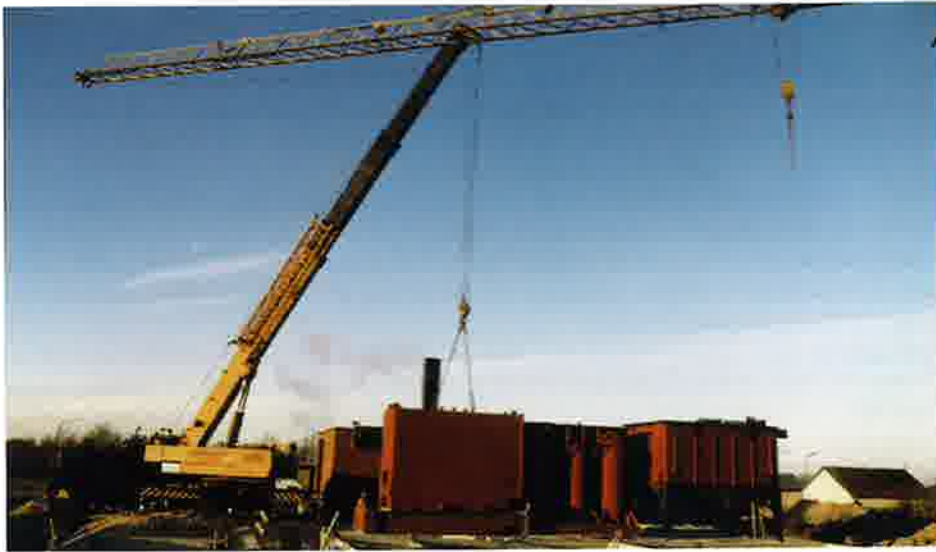
Opførelse af det flisfyrede værk på Agertoften den 26. februar 1987. Fyrboksen hænger i kranen.
