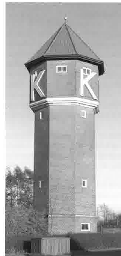
Det nye vandtårn, der blev taget i brug i 1931.
